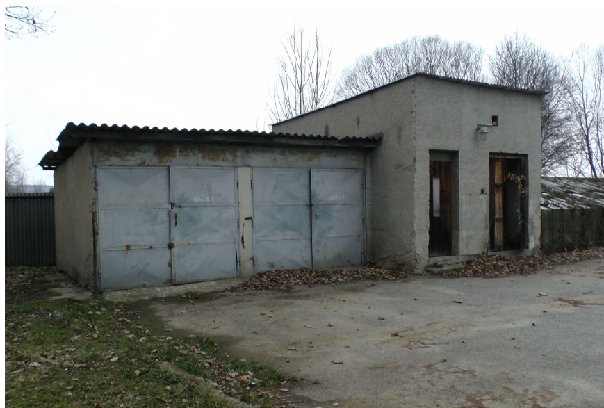
Snímek 6. Střecha garáží je z vlnitého eternitu.
