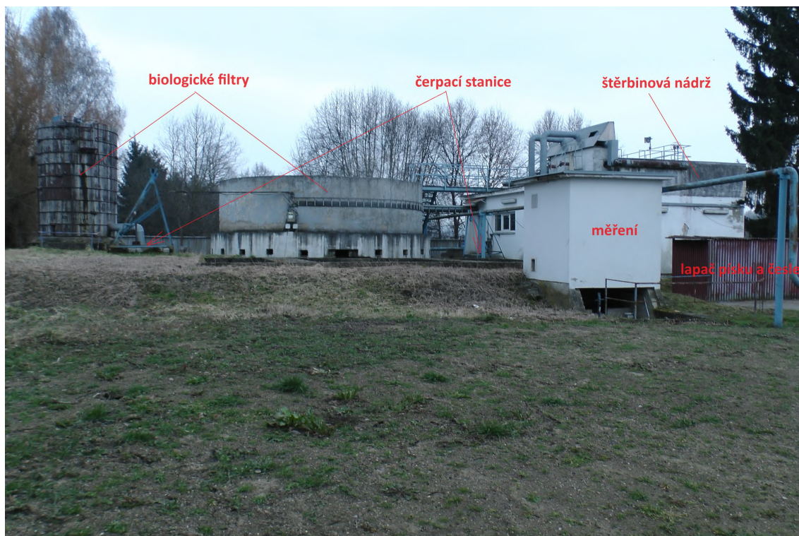
Snímek 4. Objekty ČOV při pohledu ze severovýchodního rohu areálu
