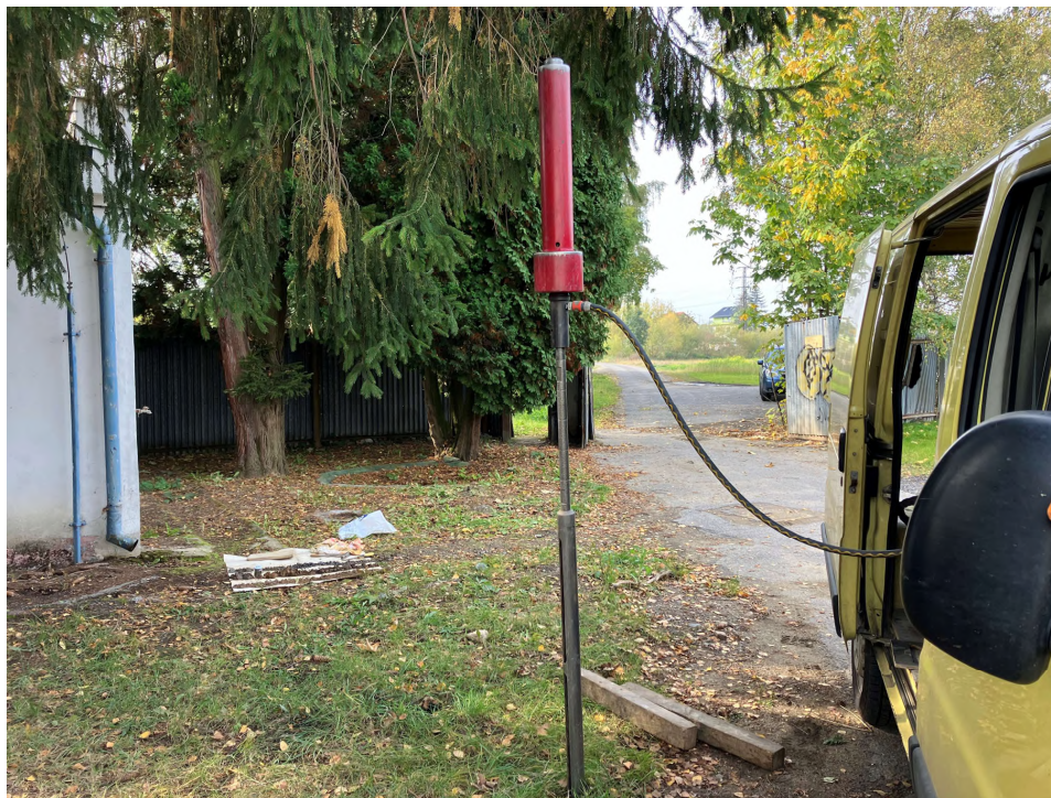
Snímek 9. Hloubení sondy ČOV 2
