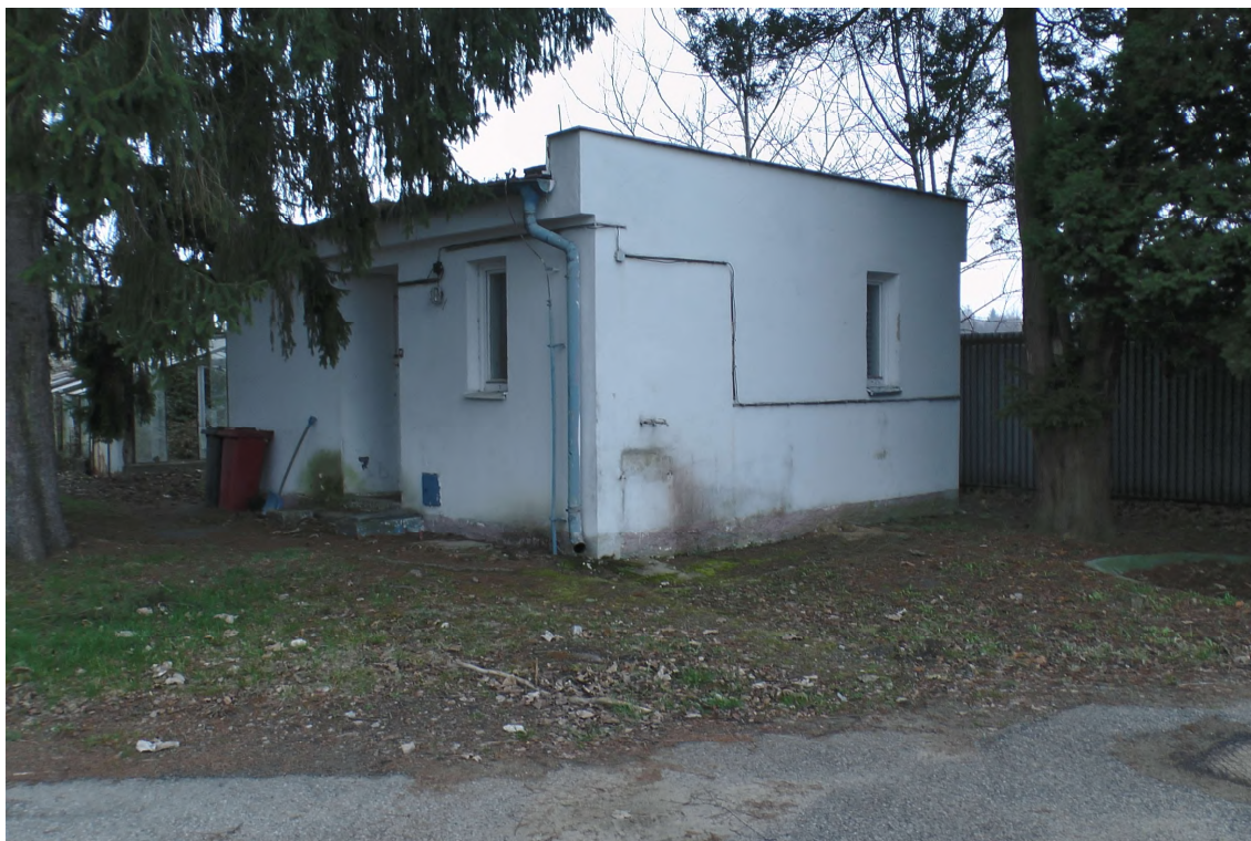
Snímek 10. Objekt obsluhy ČOV
