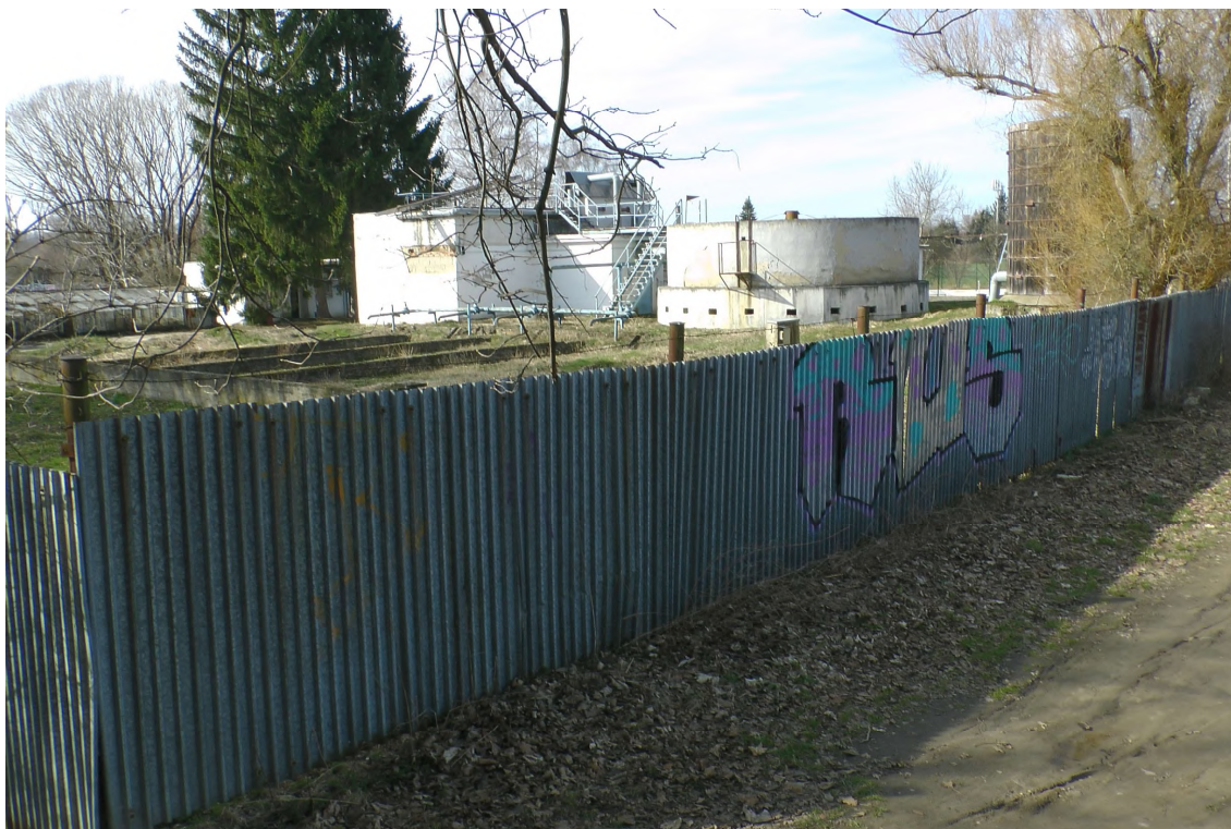
Snímek 1. Pohled severozápadním směrem na odstraňované objekty ČOV
